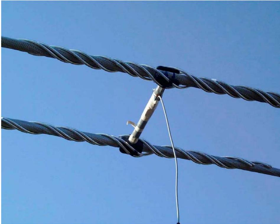
*Bild 4.12: Abstandshalter 400 mm mit Dehnungsmessstreifen*
