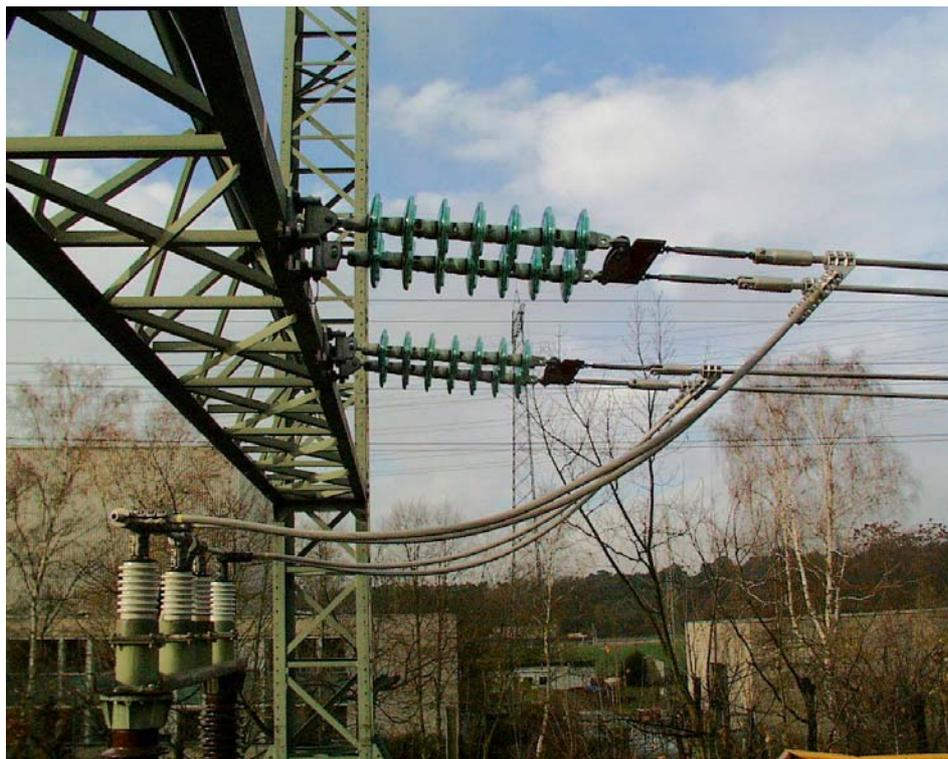
*Bild 4.5: Abspannkette am Portal Mitte (100-kV-Anordnung)*
