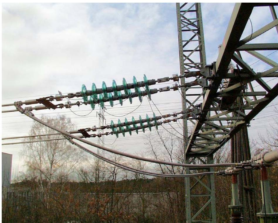
*Bild 4.6: Abspannkette am Portal Nord (100-kV-Anordnung)*
