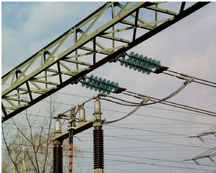
*Bild 4.3: Stromeinspeisung am Portal Mitte (100-kV-Anordnung)*
